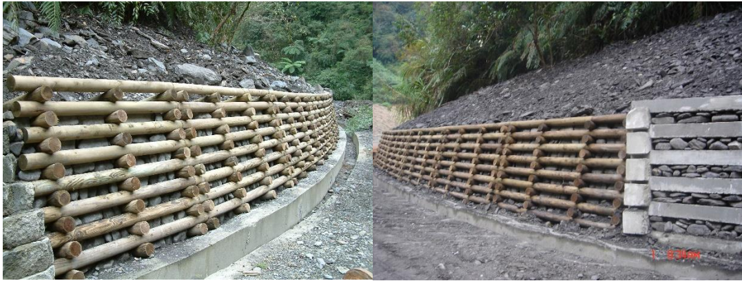
照片 1、木格框擋土牆（羅東處仁澤溫泉附近）
