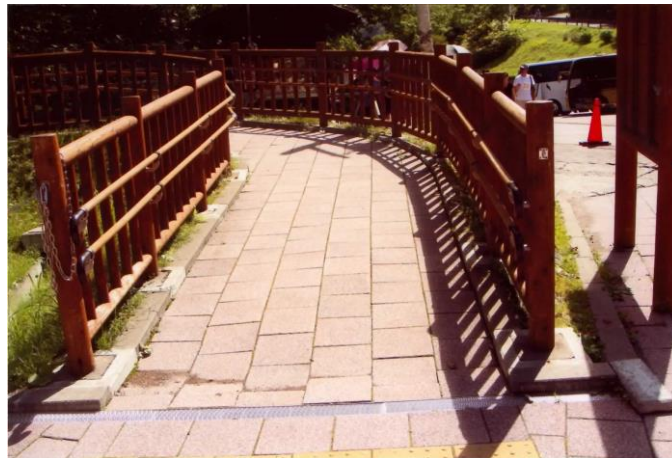
照片 5、木製圍欄
