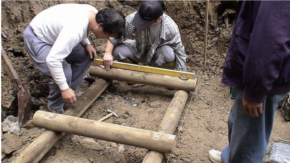
照片 4、2 號節制壩基礎丈量
